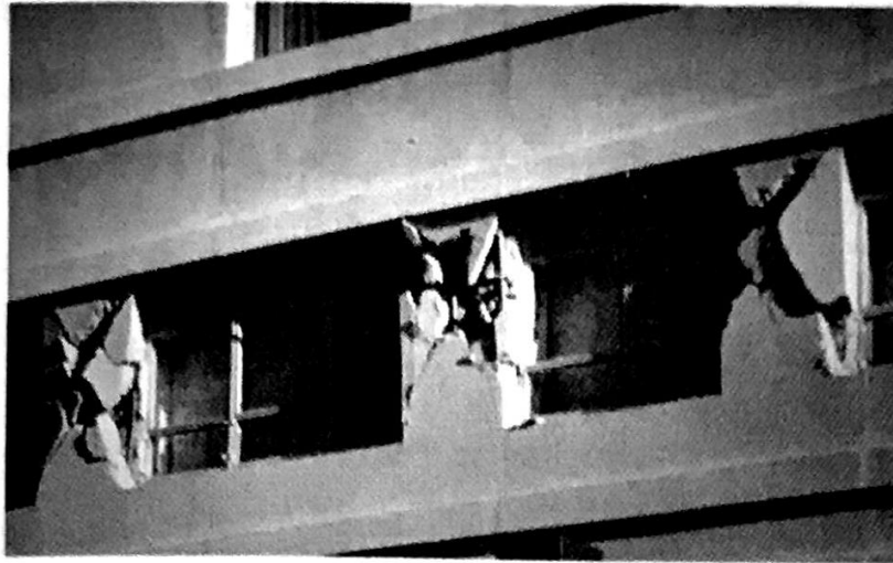
شکل ۸۴: تخریب برشی در ستون کوتاه
