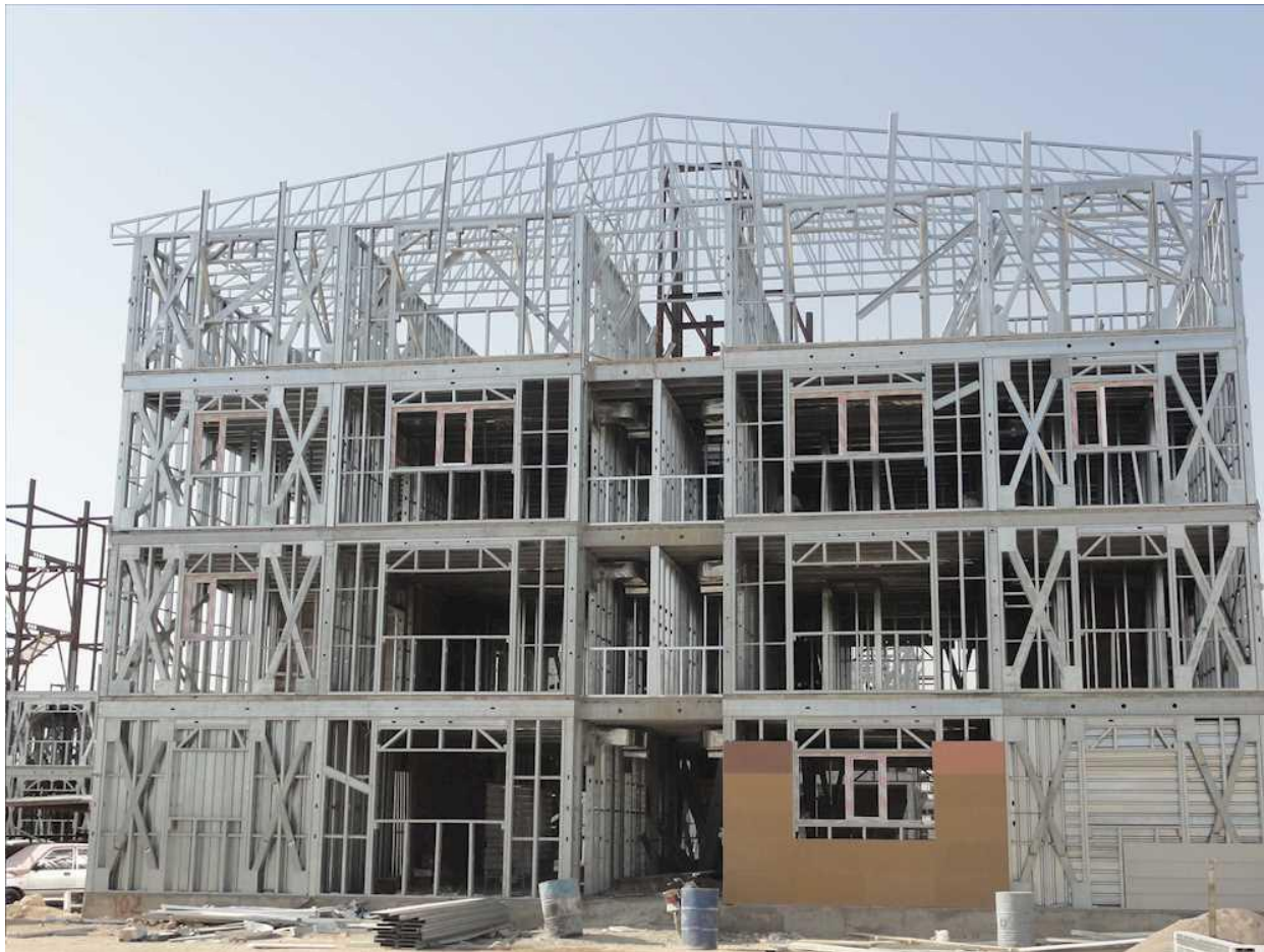
شکل ۹: یک سازه در حال ساخت با سیستم LSF
