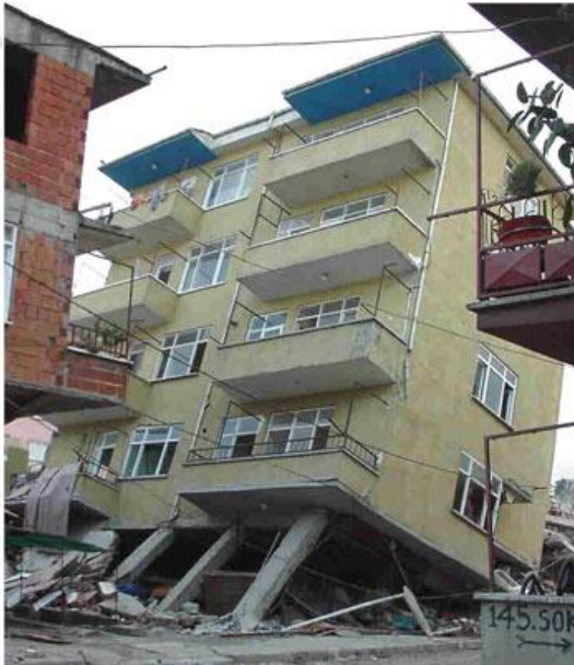
شکل ۷۱: آسیب به طبقه نرم در پایین‌ترین طبقه
