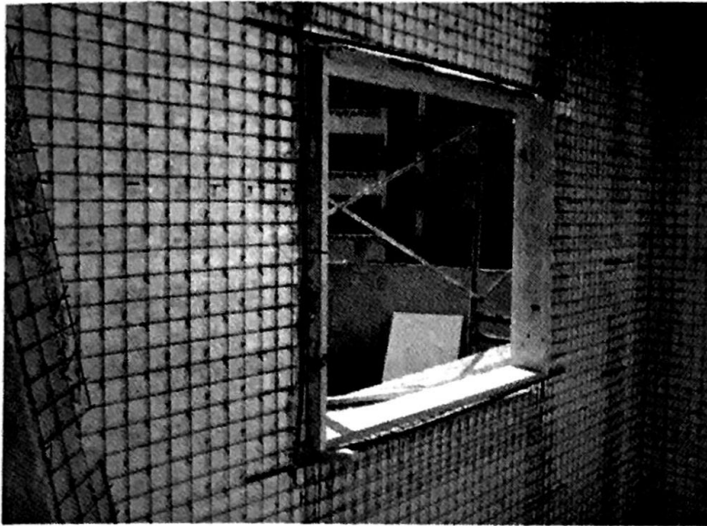
شکل ۱۰: نمونه‌ای از یک دیوار بتن پاشی سه بعدی (قبل از بتن پاشی)
